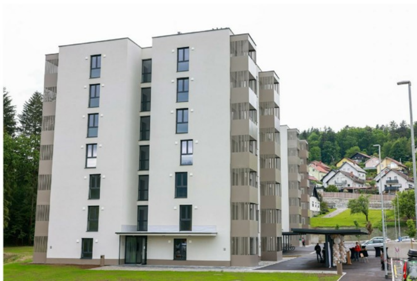
Neprofitna stanovanja na Ravnah na Koroškem. Foto: SSRS
